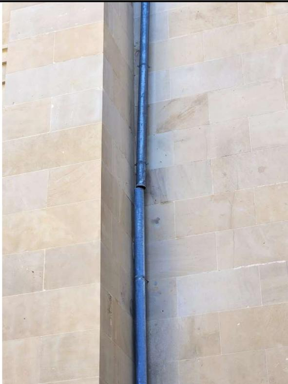
Es evidente la falta de mantenimiento puesto que tan solo se debe unir las 2 partes de la tubería, que se han soltado, y que no permiten evacuar correctamente el agua.
